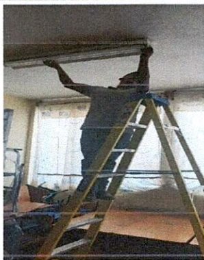
Foto 1: Mantenimiento de instalación eléctrica Durante
