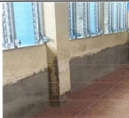
Foto 4: Mantenimiento de repello de paredes (zócalo) Durante
