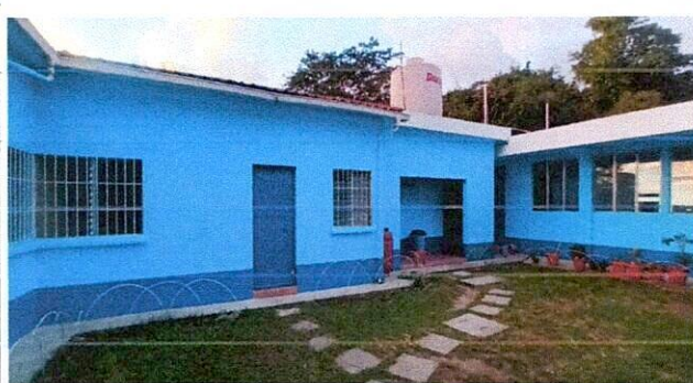
Foto 2: mantenimiento de pintura de la escuela Durante
