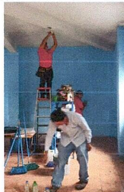
Foto 2: Mantenimiento de instalación eléctrica Durante
