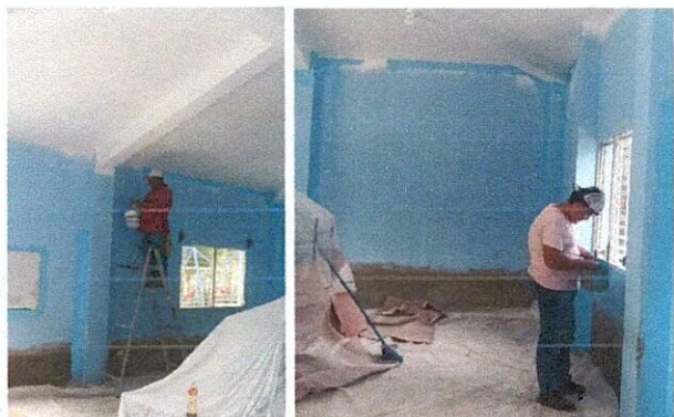
Foto 1: mantenimiento de pintura de la escuela Durante
